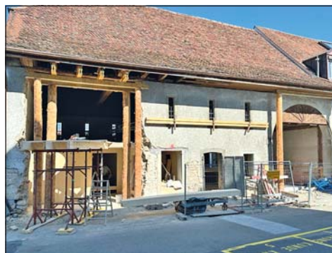
Zehntenscheune im Umbau
